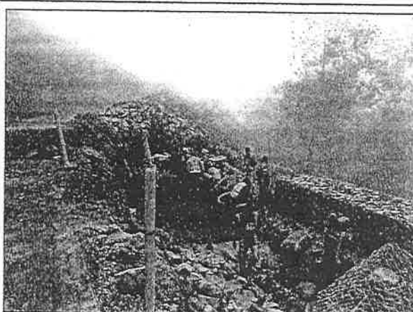
Construcción de muros de gaviones en Guativil
