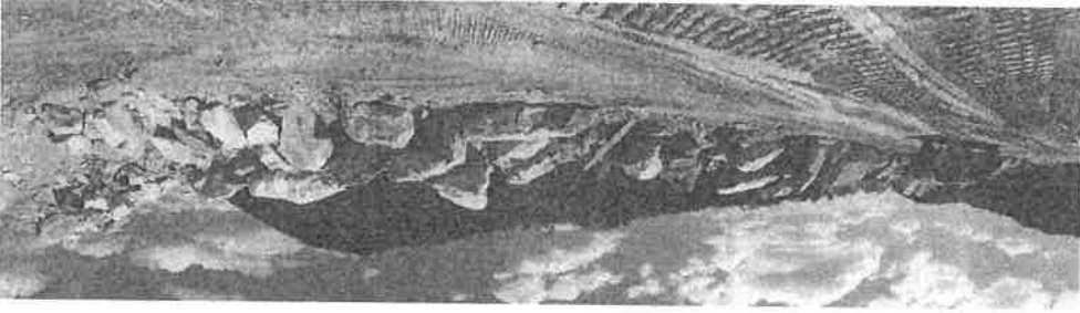
Material de roca producto de la excavación realizada para los accesos al puente
